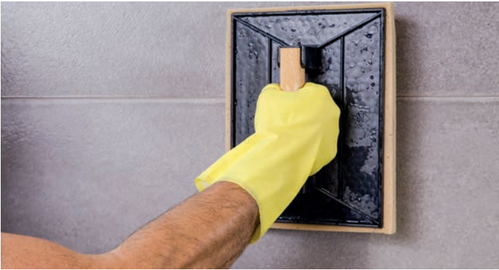
Remove any leftover grout and other dirt | Elimina los residuos de junta y demás suciedad | Éliminer les résidus du joints et autres saletés | Entfernen Sie Fugenmaterialreste und andere Verunreinigungen
