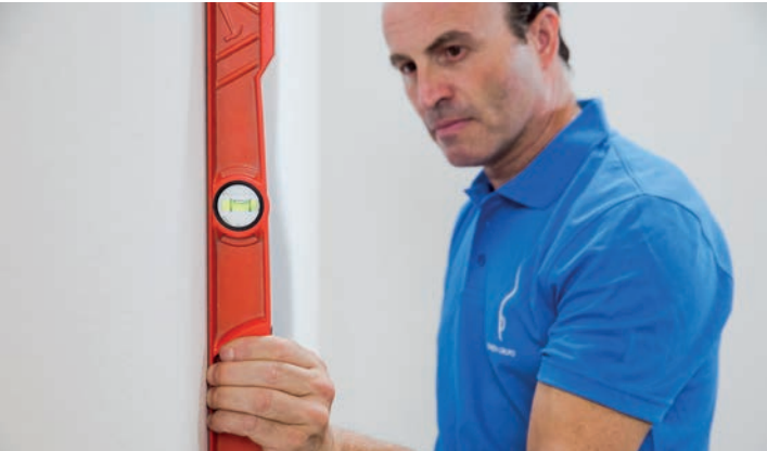
Check the level | Comprueba la nivelación | Vérifier le niveau | Überprüfen Sie die Nivellierung
