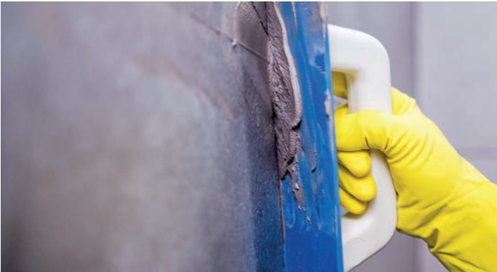
Use a grout trowel to affix the material | Utiliza una llana de rejuntado para fijar el material | Utiliser une spatule pour joints pour fixer le joint | Verwenden Sie eine Fugenkelle zum Andrücken des Materials
