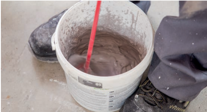
Prepare the grout | Prepara el material de rejuntado | Préparer le matériel de joint | Rühren Sie das Fugenmaterial an
